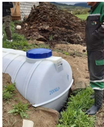
La collecte des effluents liquides est une nouveauté, et fait suite aux solutions abordables et simples, élaborées collectivement entre le GBDC, FERT et le BTPL
